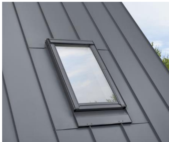
Przykładowy sposób obsadzenia okna połaciowego
